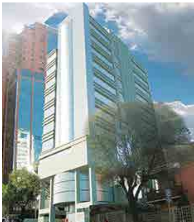
Fachada principal del edificio BBV-EDV
